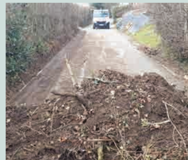
Nettoyage des filets d'eau
