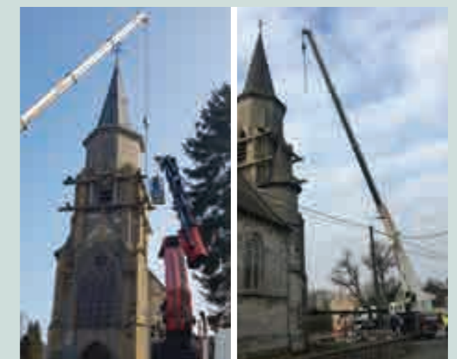
Démontage du carcan de l'église de Scry
