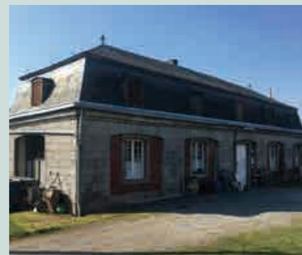
Travaux de remplacement des gouttières du local de camping de Fraiture
